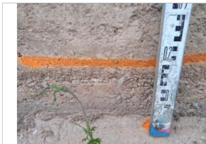
Trace sur le mur
