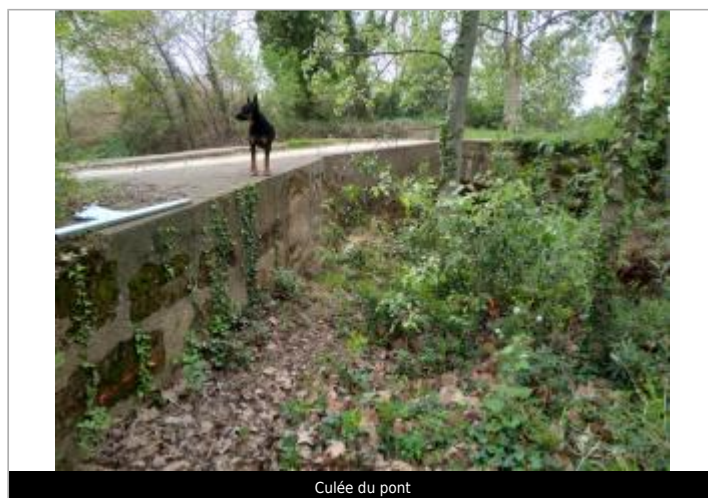
Culée du pont
