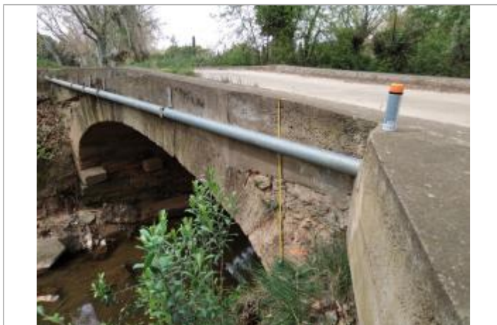
voûte du pont
