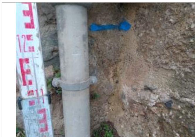
Trace sur le mur
