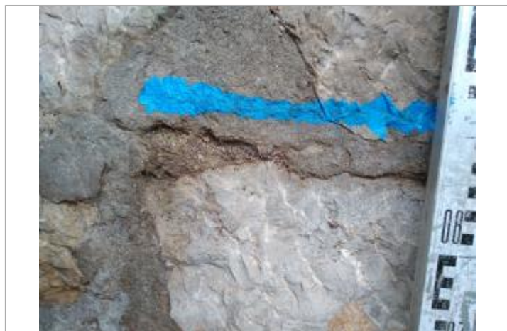
Trace sur le mur
