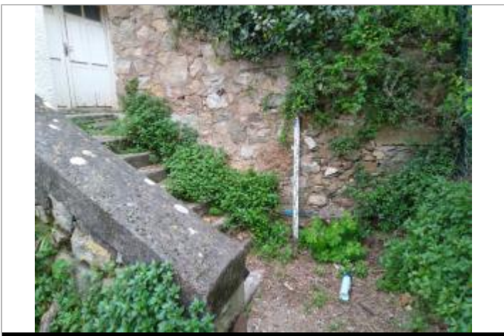
Muret des escaliers
