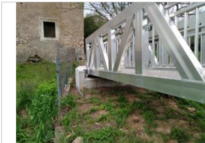
Massif béton de la passerelle
