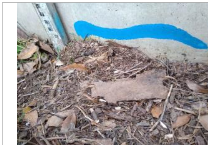
Dépôt contre le massif en béton
