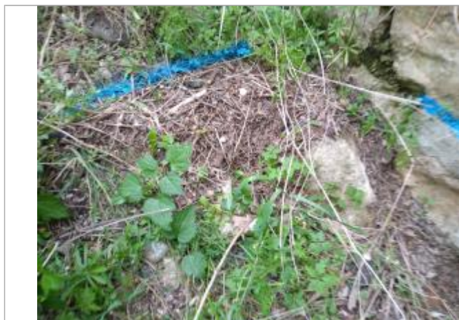
Dépôt contre la culée
