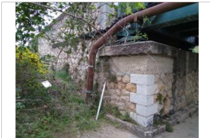
Culée du pont
