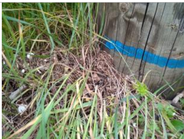
Dépôt contre le pylône
