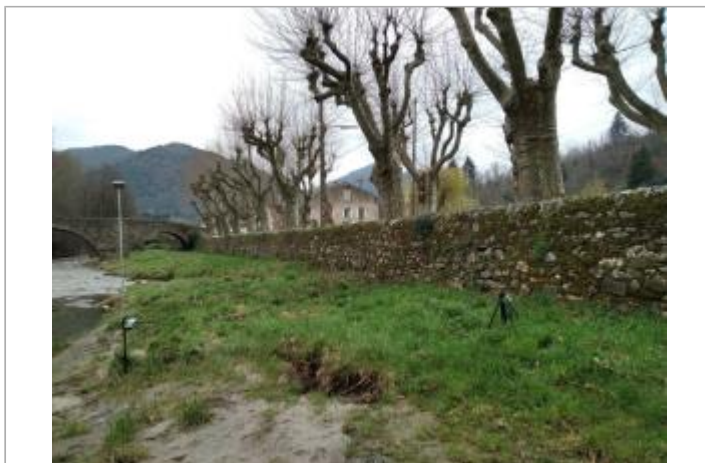
Mur de soutènement
