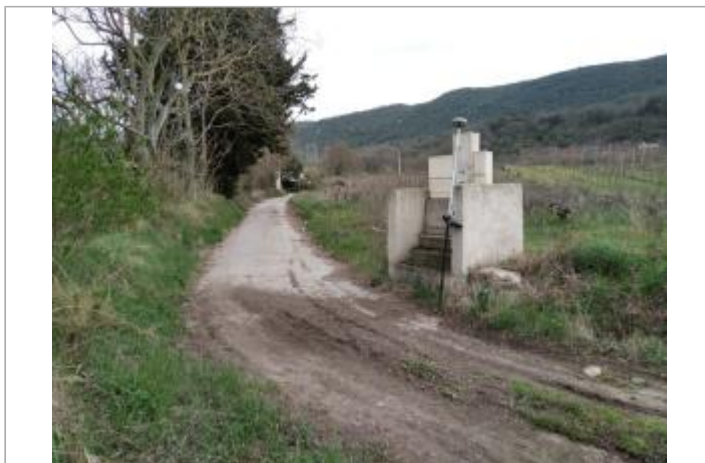
Poste de relevage
