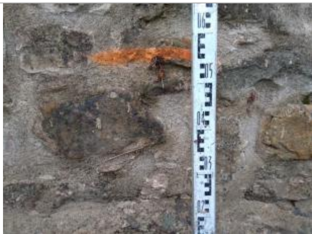
Trace sur la digue
