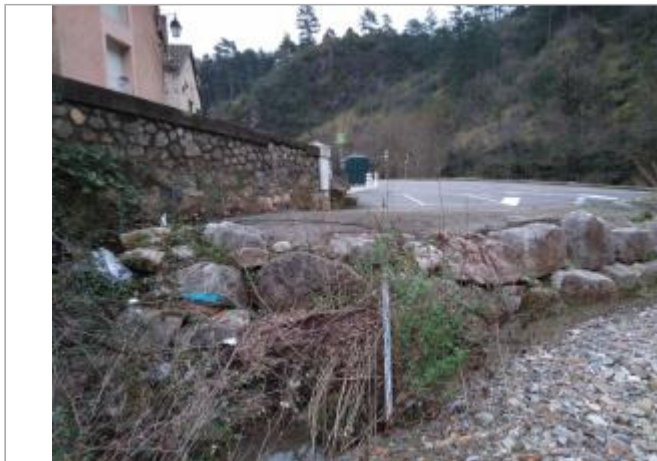
Enrochement amont du parking
