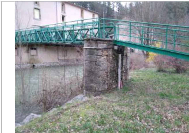
Pile de la passerelle
