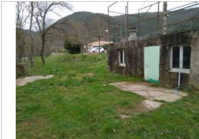
Mur du local
