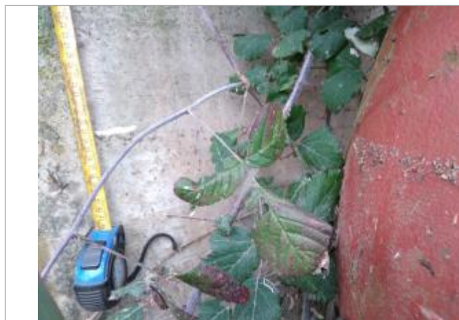
Trace sur le mur
