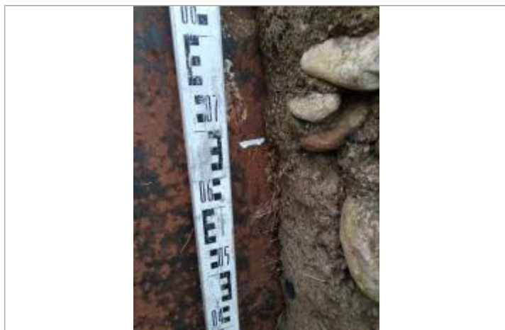
Trace sur le batardeau
