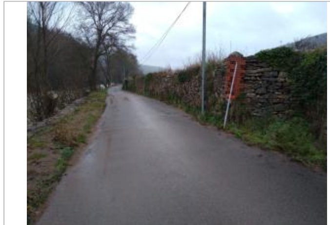
Mur de soutènement
