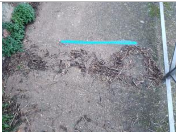
Dépôt sur la rampe
