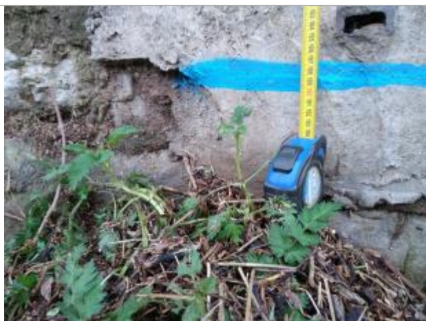
Trace sur le mur
