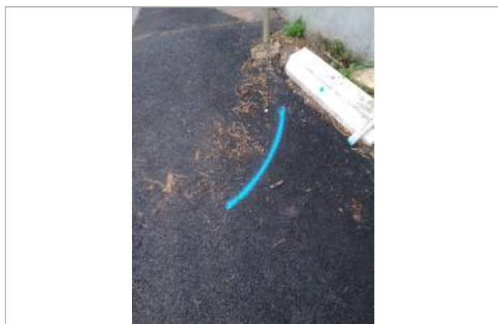
Dépôt sur la chaussée
