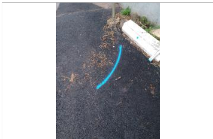
Dépôt sur la chaussée
