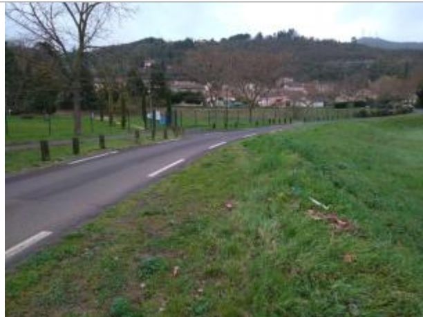
Talus de route
