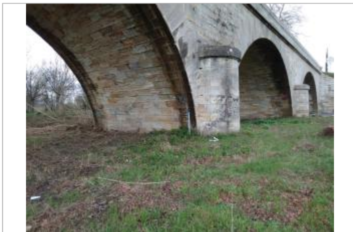
Arche du pont
