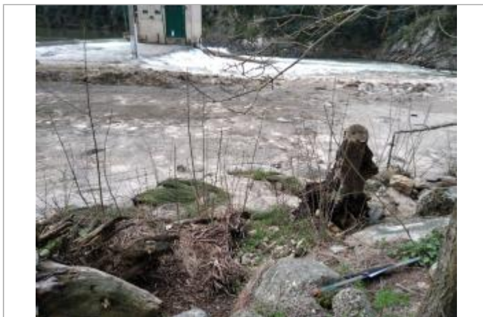
Enrochement du seuil
