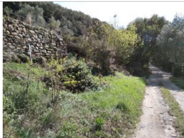
Mur de soutènement en pierre
