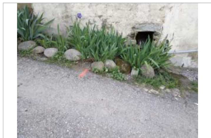
Débris végétaux et témoignage de riverain
