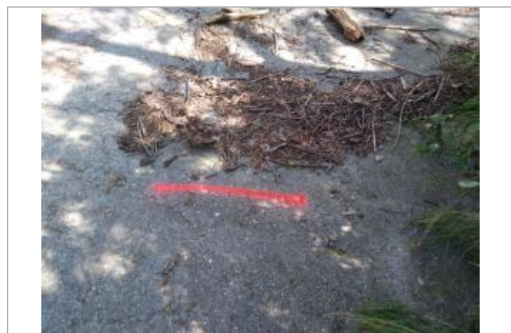
Dépôt sur la chaussée
