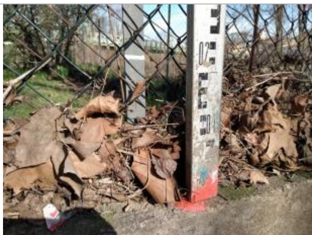
Débris végétaux accrochés au grillage
