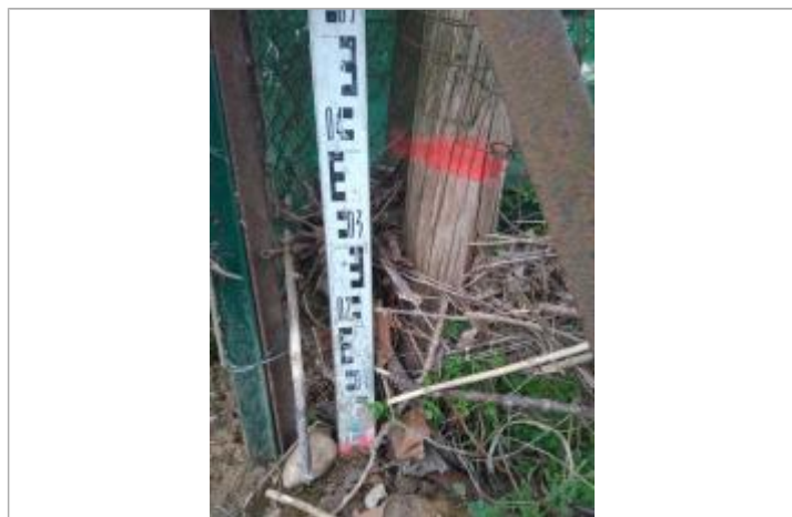
Débris végétaux accrochés au grillage
