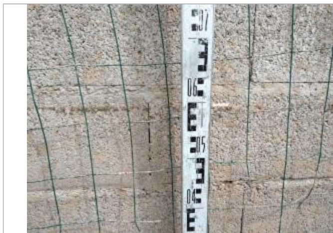
Trace sur le mur en parpaings
