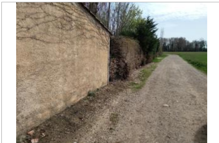
Mur du cabanon
