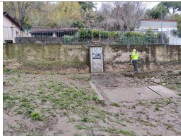
Armoire en béton
