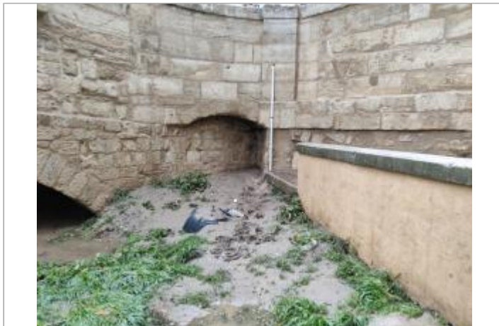
Culée du pont
