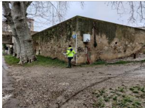
Mur de soutènement
