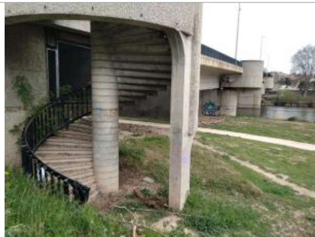
Axe de l'escalier
