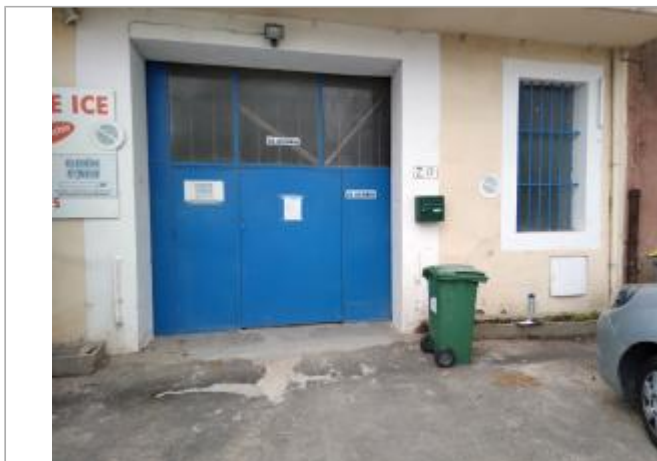
Mur du bâtiment
