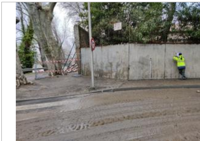
Mur de soutènement
