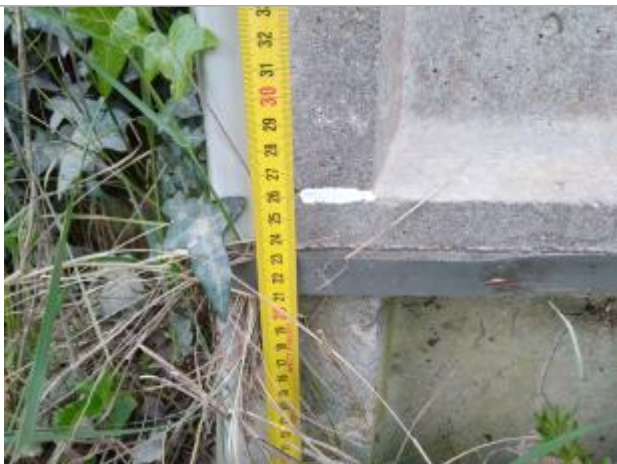
Trace sur le pylône
