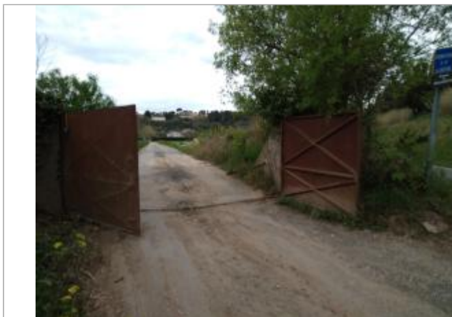
Portail de la digue
