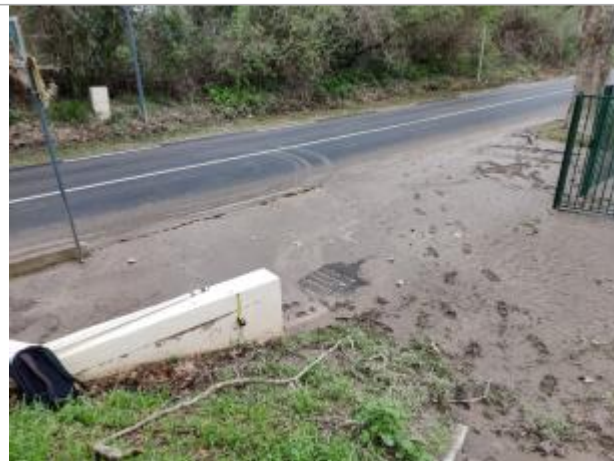
Muret du transformateur
