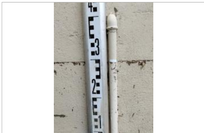
Trace sur le mur
