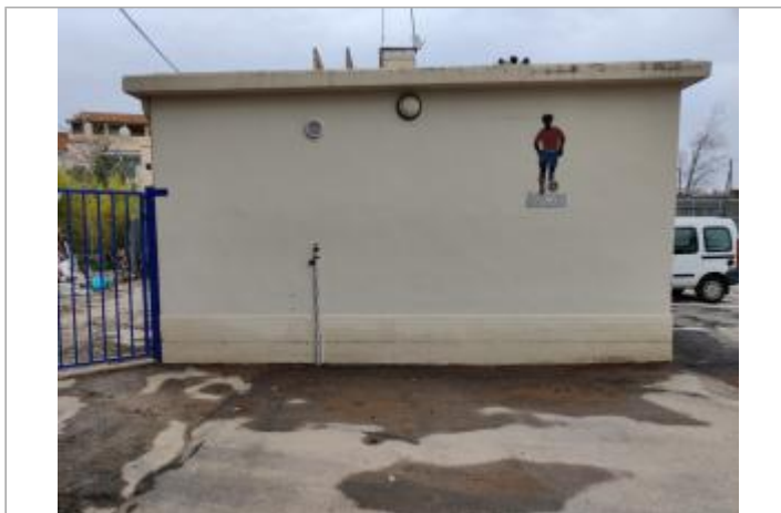
Mur des vestiaires
