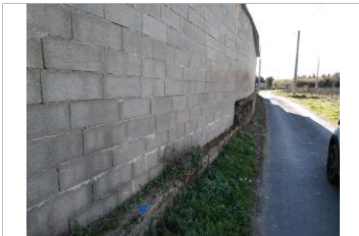
Mur du bâtiment
