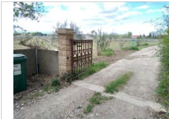
Muret espace poubelles
