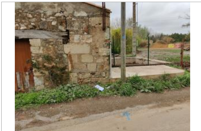
Angle du mur de la grange
