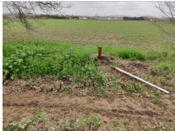
Plot béton du piézomètre
