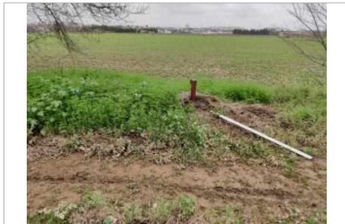
Plot béton du piézomètre
