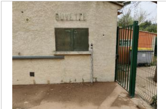
Mur du bâtiment
