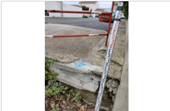
Poutre béton de soutènement
