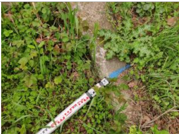
Trace sur l'ouvrage
