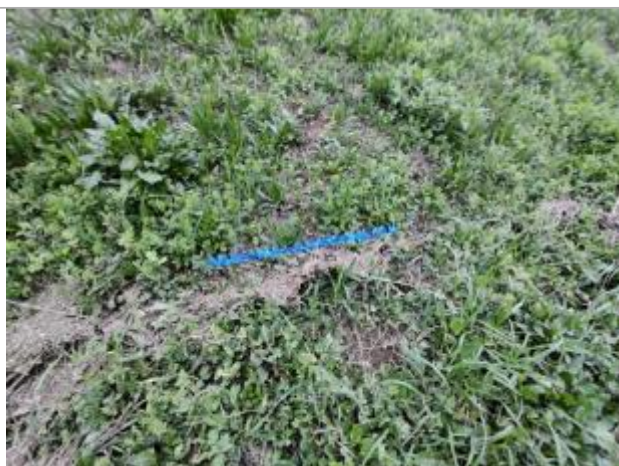
Dépôt contre la digue
