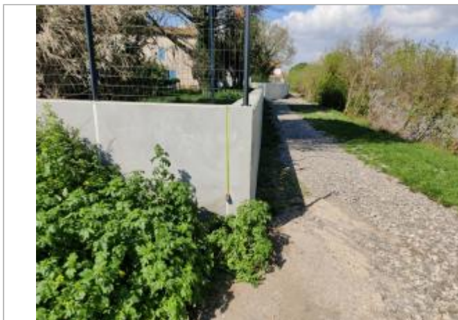
Angle du mur de soutènement
